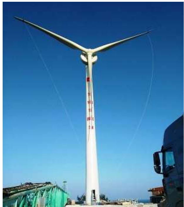
Thi công lắp đặt tổ hợp điện gió
